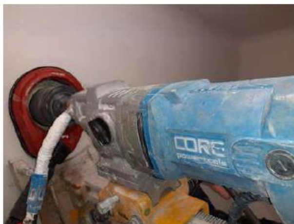
Image 8 : carottage à l'aide d'un appareil à eau et d'un système de récupération des boues (détail). ©AD Marne
